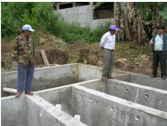
Construction du bassin de décantage des eaux usées.
