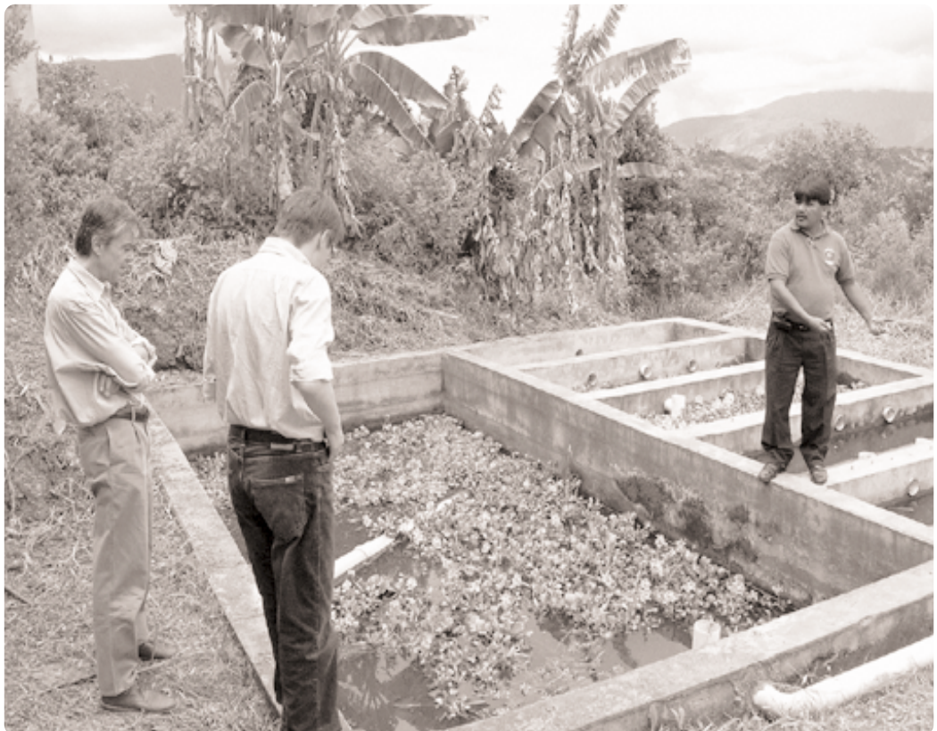
Bassin de décantage des eaux usées
